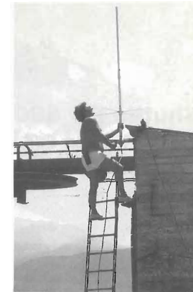
Le fasi dell'installazione dell'antenna.
